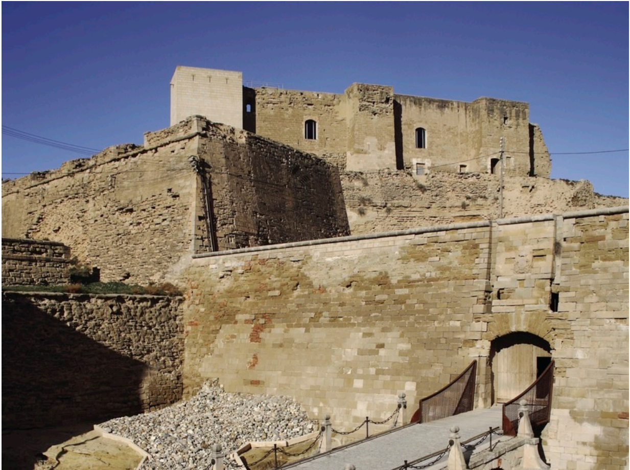
Die mittelalterliche Stadtmauer von Lleida an der Seu Vella © Miguel Raurich
