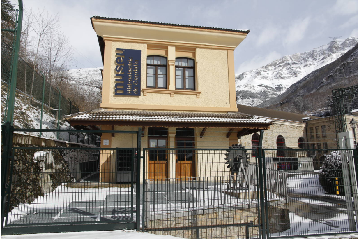
Das Hydroelektrische Museum im Vall de Fosca
