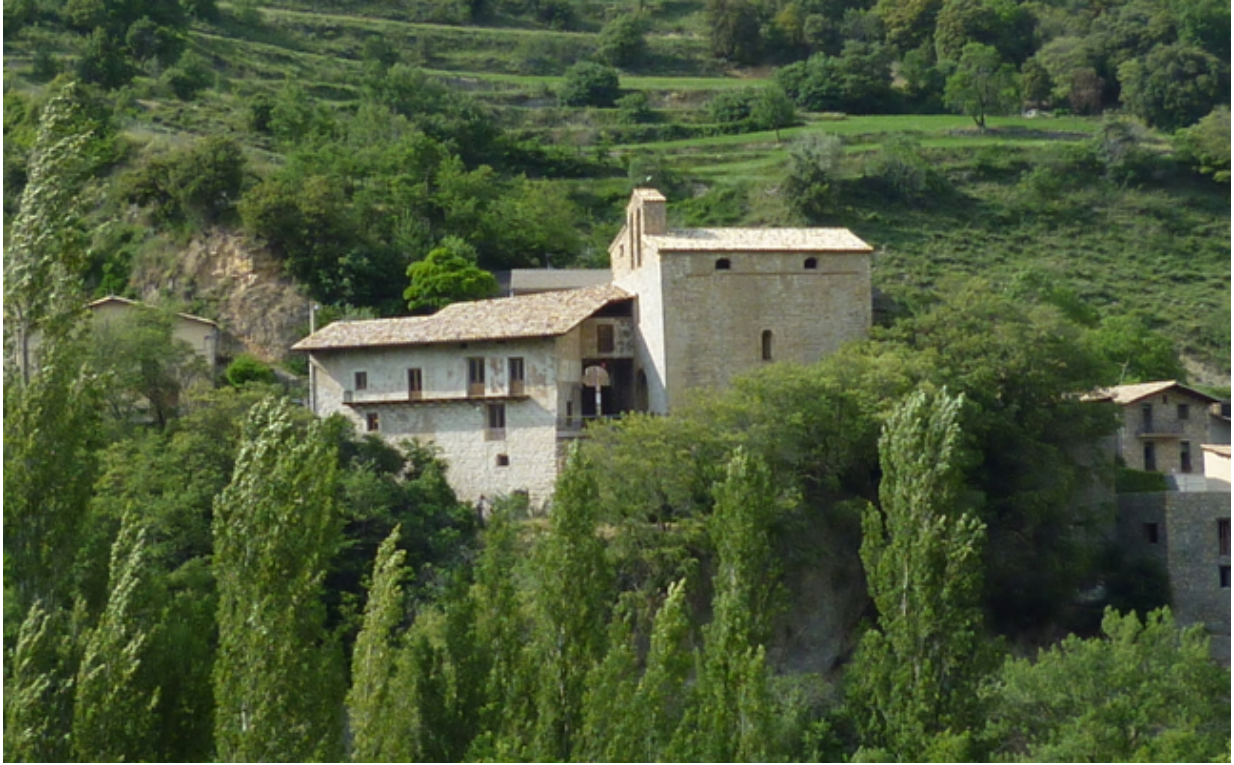
Besucherzentrum und Museum – das renovierte romanische Pfarrhaus in Alinyà
