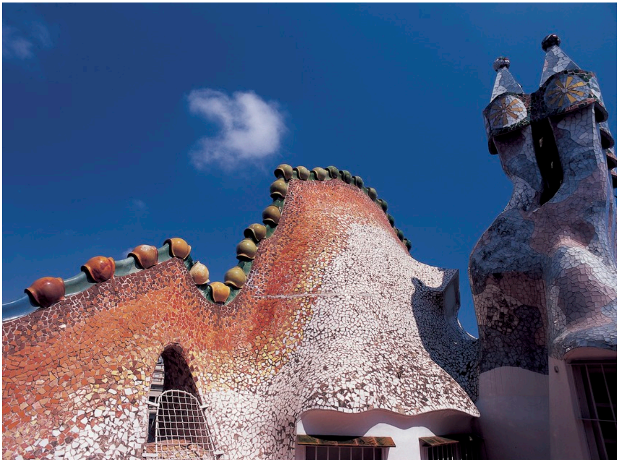
Detail des Dachs der Casa Batlló © Imagen M.A.S.
